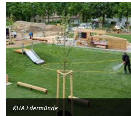
Bau des Klimaparks in Zierenberg
